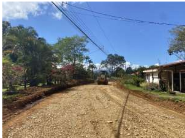
Fotografía N°61 Proyecto Asfalto Santa Elena Ejecución
