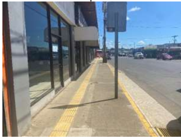
Fotografía N°35 Proyecto Aceras de San Isidro Tramo Salvadoreña-Pizza Hut Después
