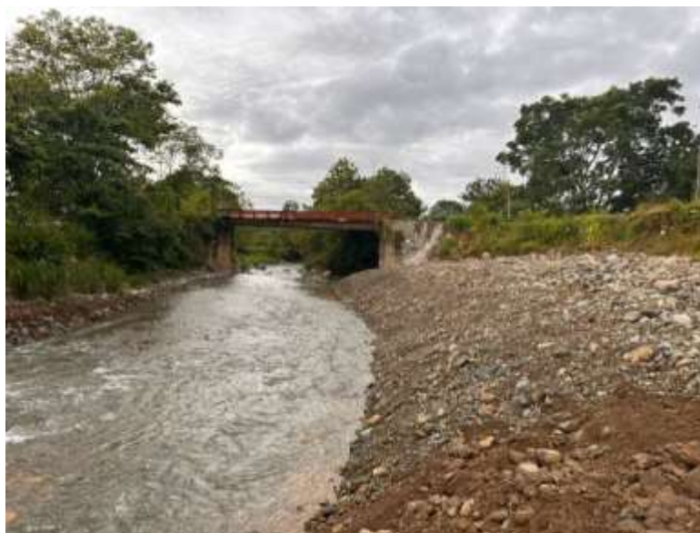
Fotografía 93. Trabajos en el sector Río San Isidro, Sector Puente Rojo
