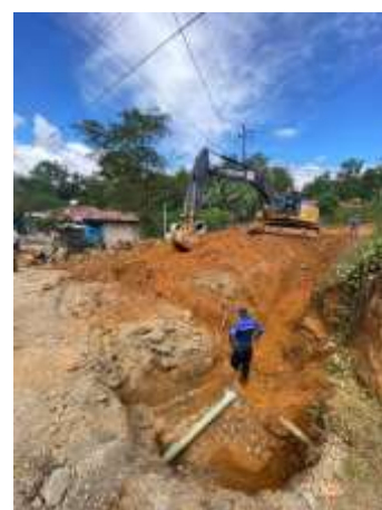
Fotografía N°59 Proyecto Asfalto Santa Elena Ejecución
