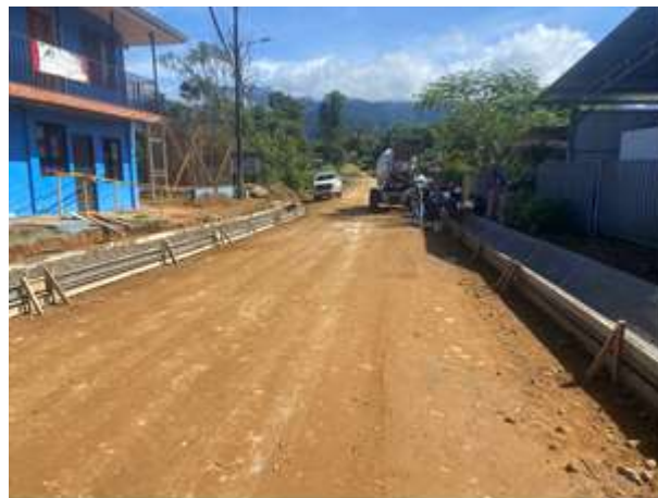
Fotografía N°57 Proyecto Asfalto Santa Elena Ejecución
