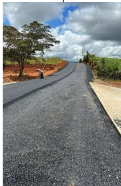
Fotografía N°79 Proyecto Asfaltado Pavones- Cocorí Después
