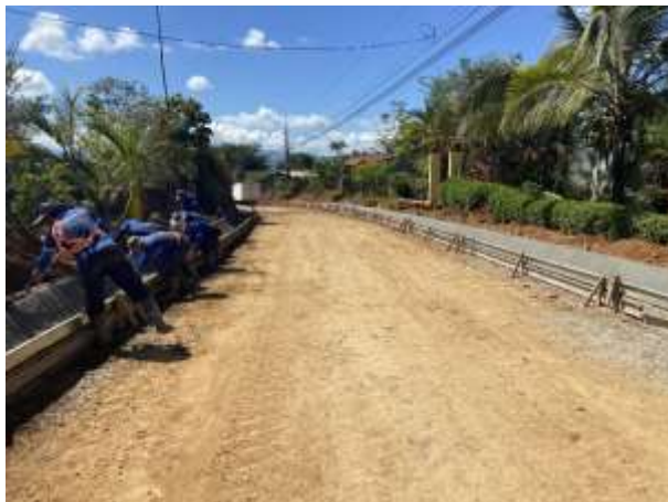
Fotografía N°60 Proyecto Asfalto Santa Elena Ejecución
