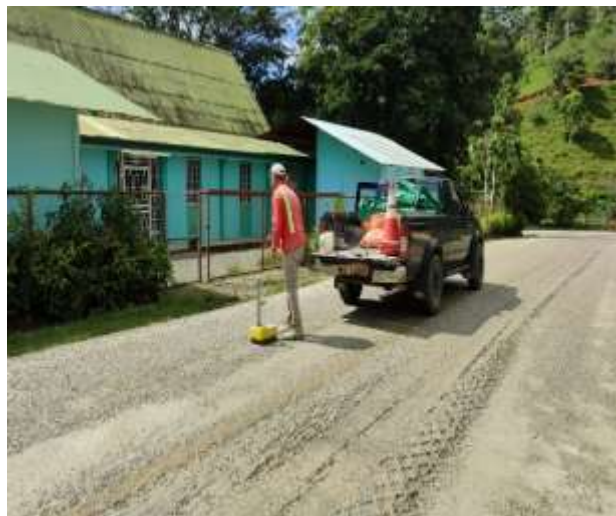
Fotografía N°76 Proyecto San Rafael de Platanares Antes
