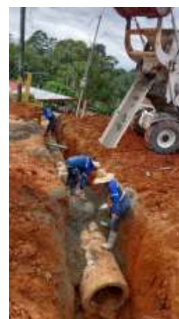
Fotografía N°55 Proyecto Asfalto Santa Elena Paso de alcantarilla reubicado Ejecución
