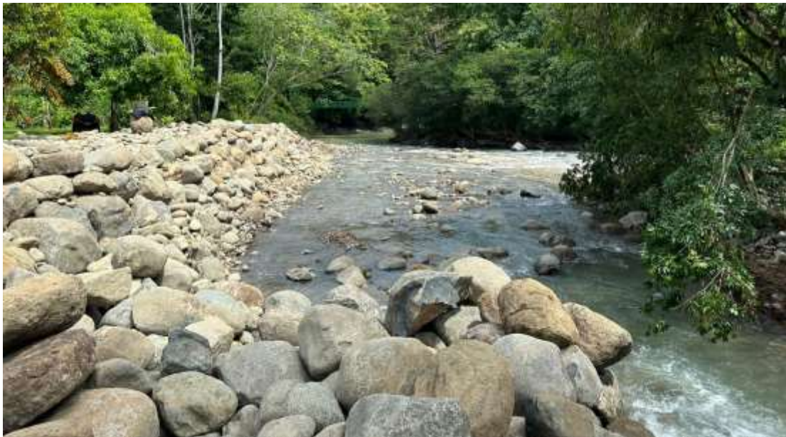
Fotografía 83. Protección de márgenes
