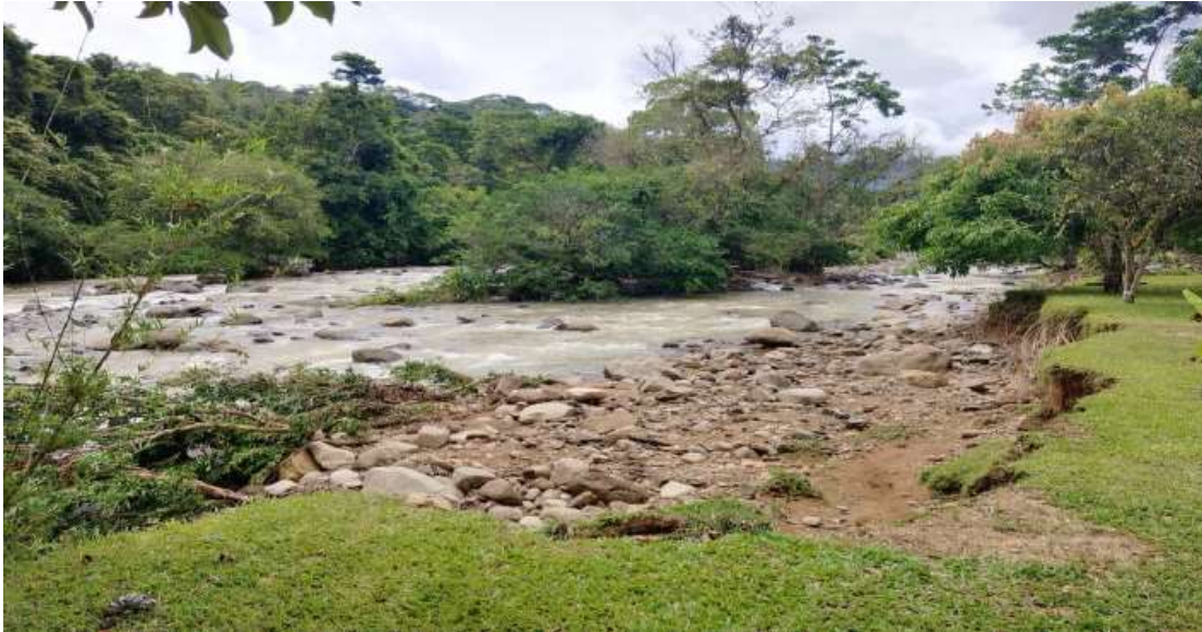
Fotografía 82. Condición antes de ser intervenido
