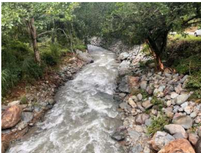
Fotografía 94. Trabajos en río Quebradas, Sector Morazán
