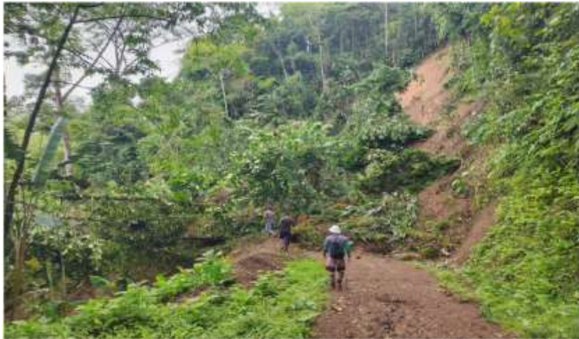
Fotografía 86. Trabajos en el sector de Piedras Blancas de Río Nuevo.
