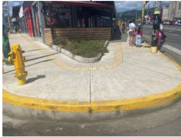
Fotografía N°33 Proyecto Aceras de San Isidro Tramo Salvadoreña-Pizza Hut Después
