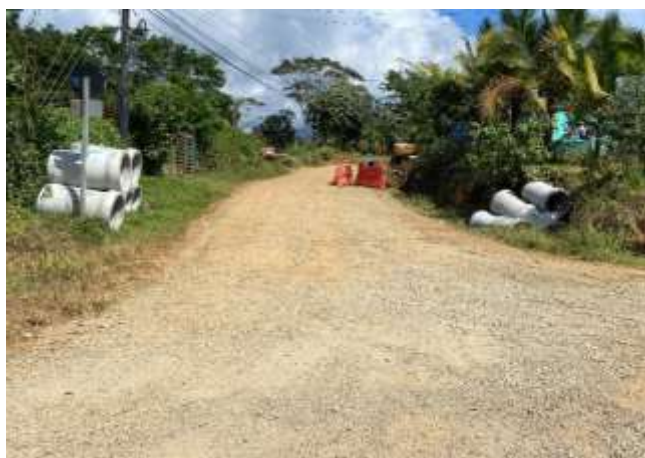
Fotografía N°58 Proyecto Asfalto Santa Elena avenida 2, costado Antes
