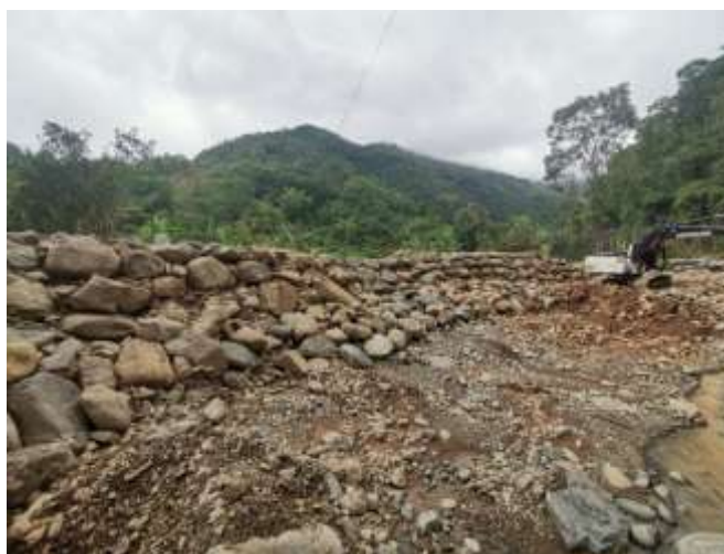
Fotografía 91. Trabajos en el sector de Chucuyo, Rivas
