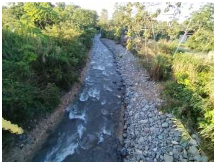
Fotografía 97. Trabajos en el sector de Gravilias, San Andrés
