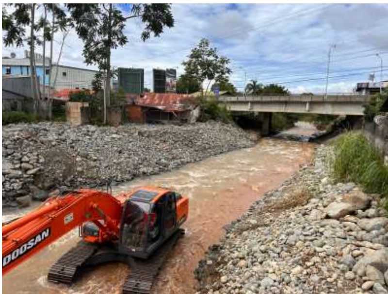
Fotografía 92. Trabajos en el sector Río San Isidro, Sector Fuerza Pública.
