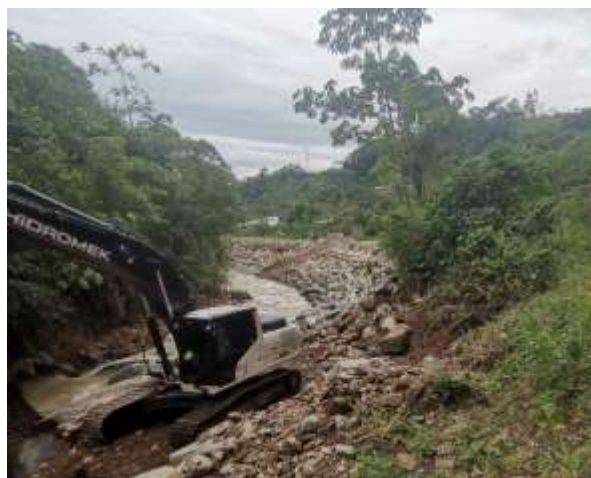
Fotografía 90. Trabajos en el sector de Chucuyo, Rivas
