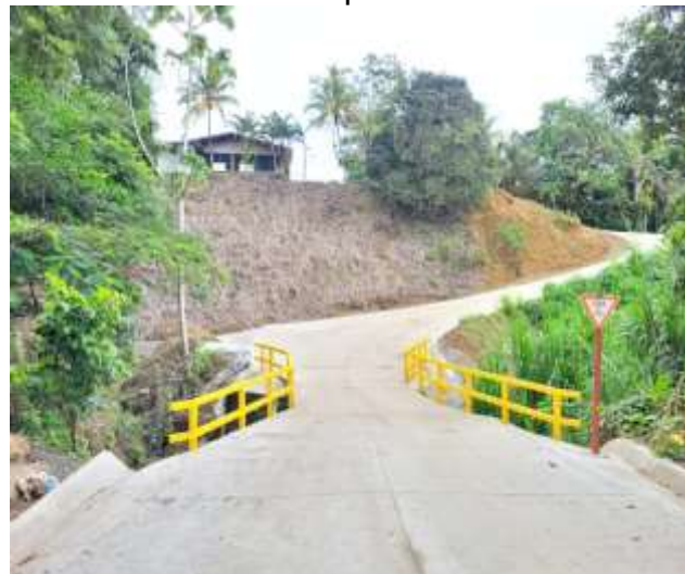
Fotografía N°81 Proyecto Cementado Santa Lucía Después
