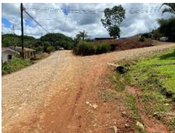
Fotografía N°54 Proyecto Asfalto Santa Elena Paso de alcantarilla a remover Antes
