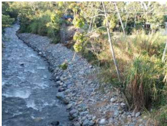
Fotografía 96. Trabajos en el sector de Gravilias, San Andrés
