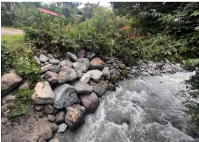
Fotografía 95. Trabajos en río Quebradas, sector puente Quebradas
