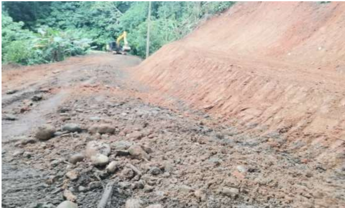
Fotografía 54. Trabajos en el sector de Rafiki de Río Nuevo.
