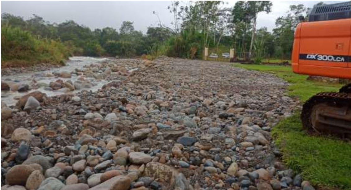
Fotografía 66. Trabajos en el sector de Fweramongo.
