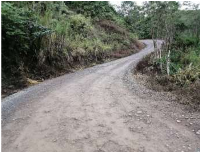
Fotografía N°48 Proyecto La Sierra Antes
