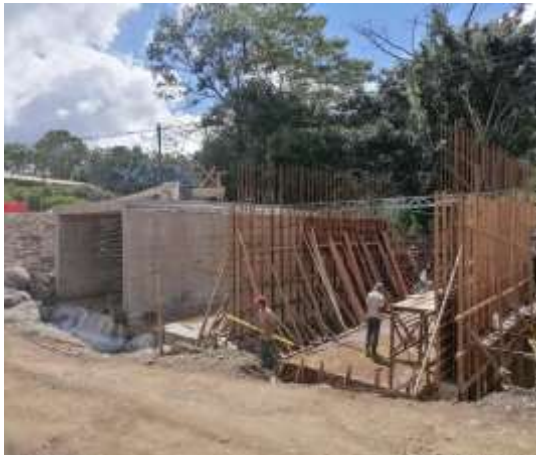
Fotografía 22. Proyecto en Ejecución
