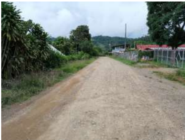
Fotografía 23. Proyecto en Ejecución
