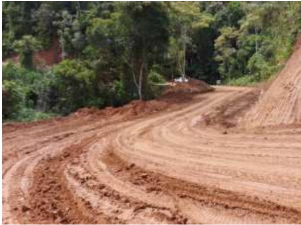
Fotografía 40. Conformación y Gaveteo
