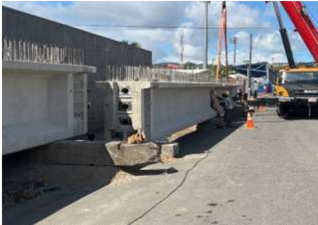
Fotografía 42. Avance de Obra, unión de vigas en sitio
