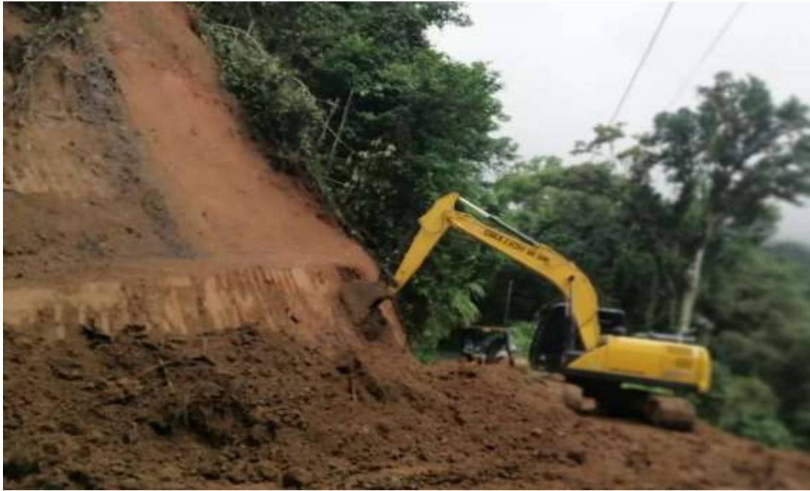
Fotografía 53. Trabajos en el sector de Rafiki de Río Nuevo.
