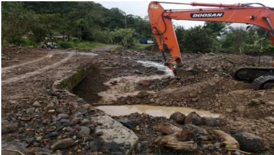
Fotografía 59. Trabajos en el sector de quebrada El Flaco en el Llano de Río Nuevo.
