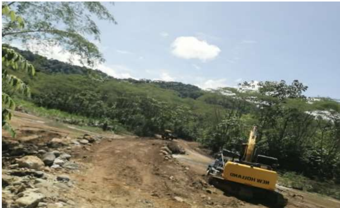
Fotografía 58. Trabajos en el sector Rafiki de Río Nuevo.
