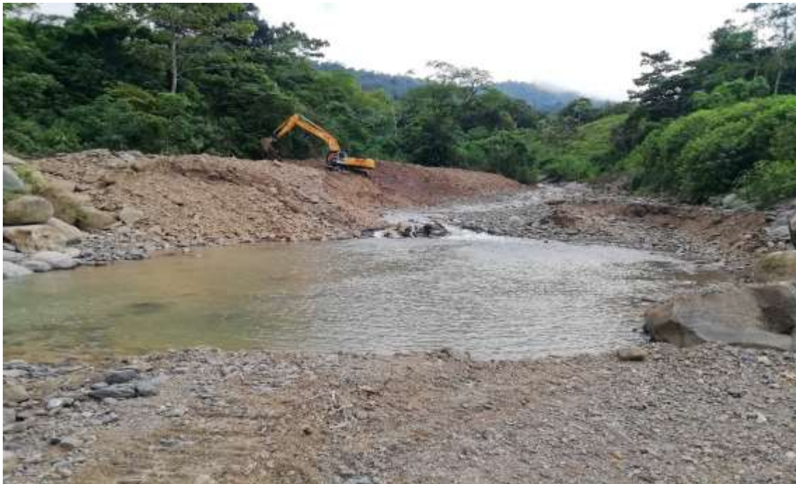
Fotografía 50 . Trabajos en el sector de Quebrada Clementina.
