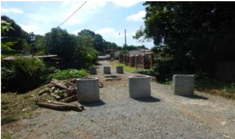
Fotografía 20. Paso de alcantarilla existente, Antes de intervenir
