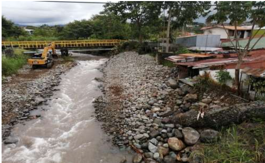
Fotografía 64. Trabajos en el sector de la Fuerza Pública.
