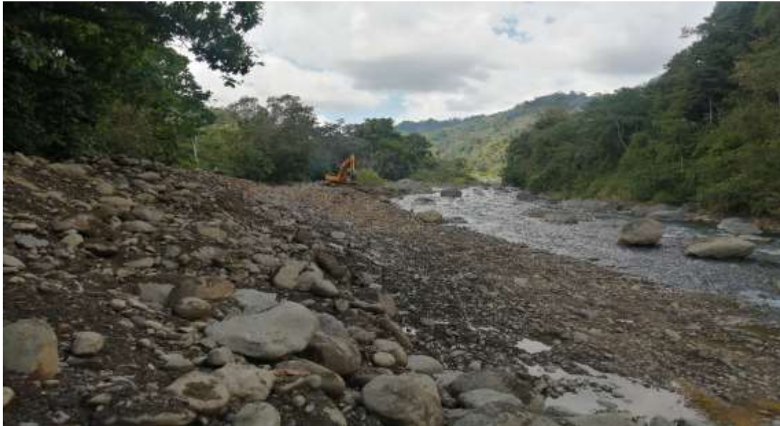
Fotografía 49 . Trabajos en el sector de El Llano de Río Nuevo.
