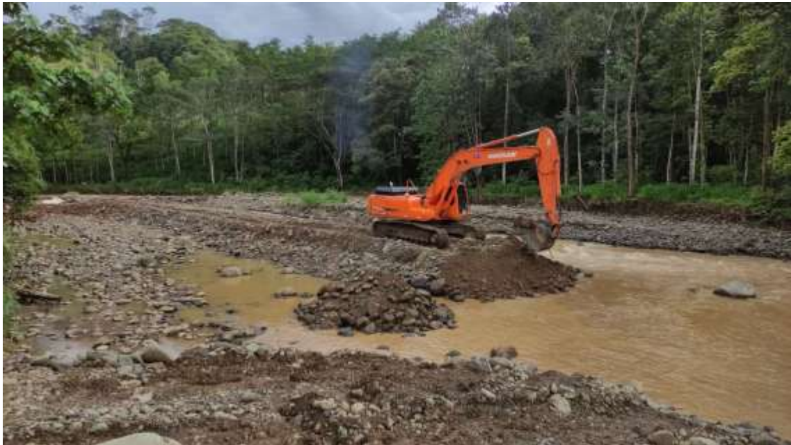
Fotografía 62. Trabajos en el sector de San Juan de Dios de Barú.
