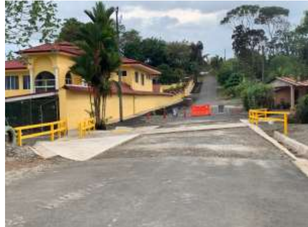
Fotografía 28. Proyecto Finalizado Vista Este- Oeste
