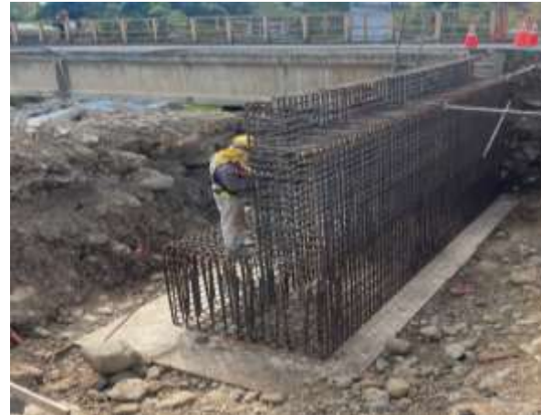
Fotografía 43. Avance de Obra, Armadura de Bastiones
