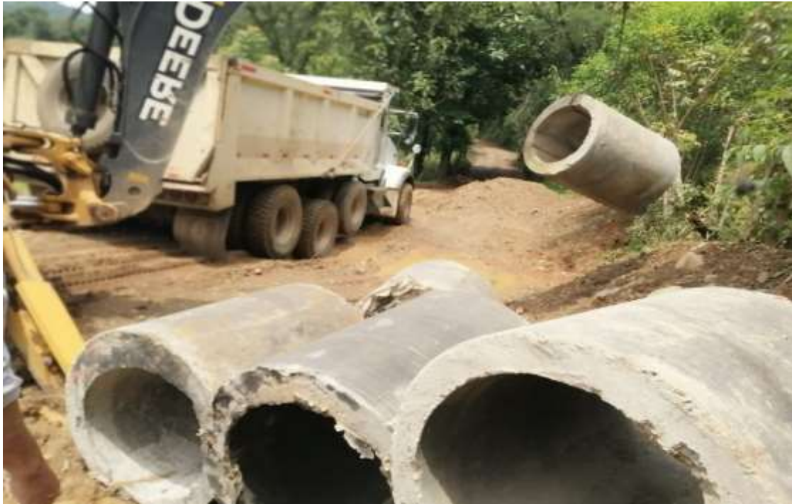
Fotografía 57. Trabajos en el sector Rafiki de Río Nuevo.
