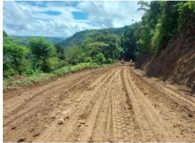
Fotografía 41. Proyecto en ejecución
