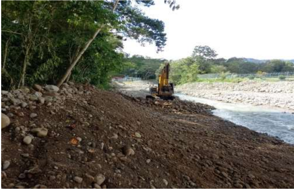
Fotografía 63. Trabajos en el sector de Polideportivo
