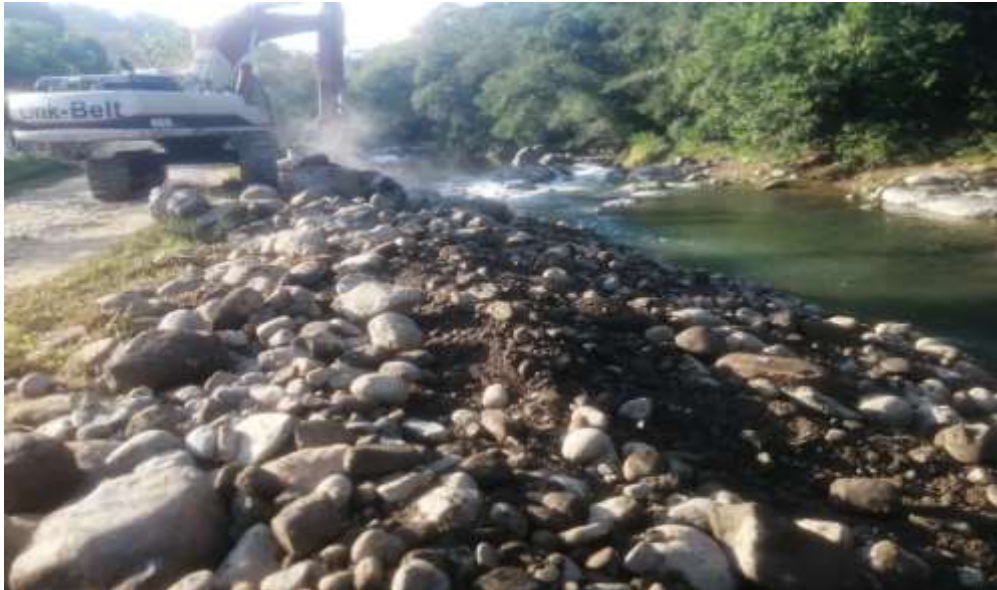
Fotografía 50. Trabajos en el sector de La Guaria.
