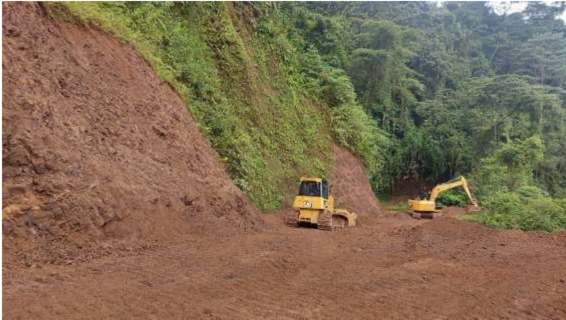
Fotografía 52. Trabajos en el sector de Piedras Blancas de Río Nuevo.
