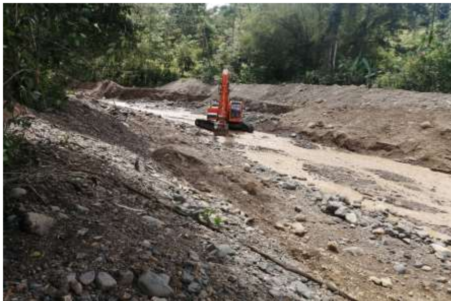
Fotografía 60. Trabajos en el sector de quebrada El Flaco en el Llano de Río Nuevo.
