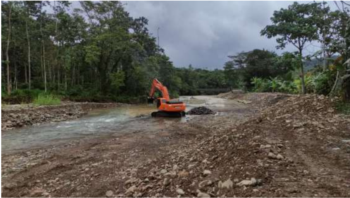
Fotografía 61. Trabajos en el sector de San Juan de Dios de Barú.
