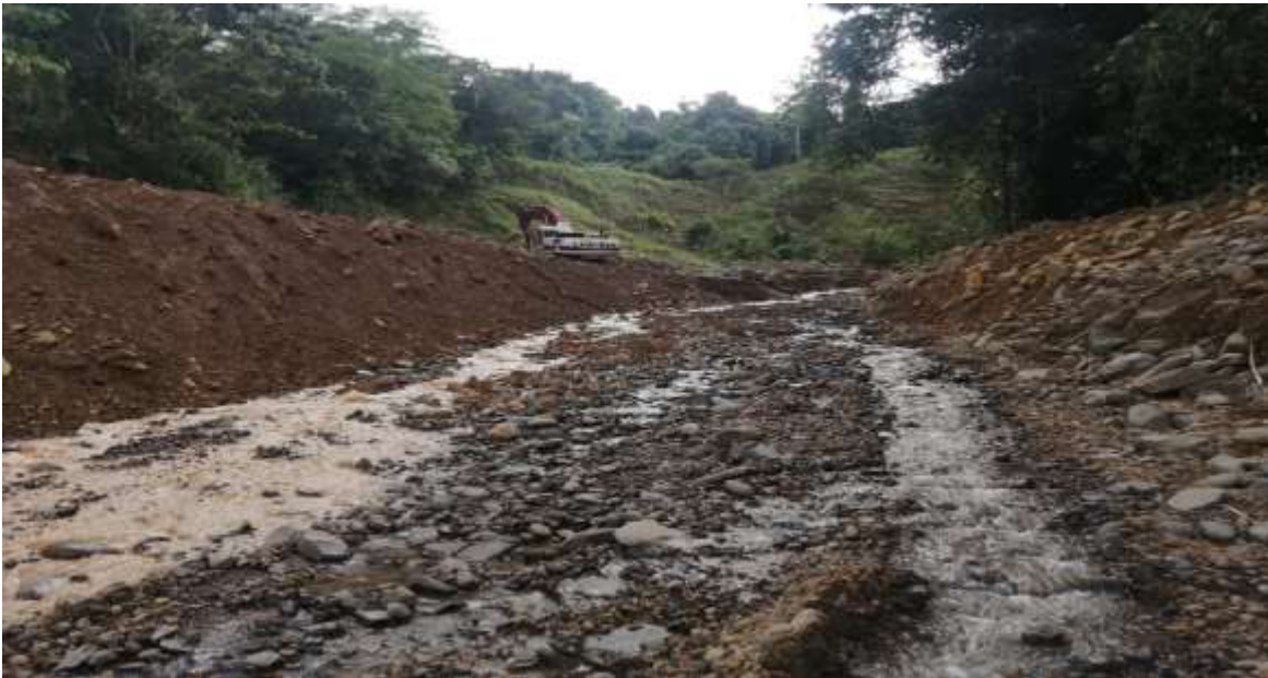
Fotografía 55. Trabajos en el sector de Quebrada Cecilia en el Brujo de Río Nuevo.
