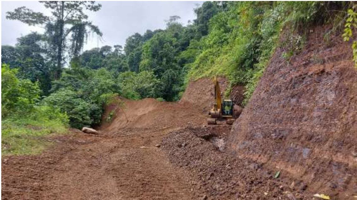
Fotografía 53. Trabajos en el sector de Piedras Blancas de Río Nuevo.
