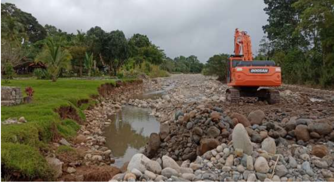
Fotografía 65. Trabajos en el sector de Fweramongo.
