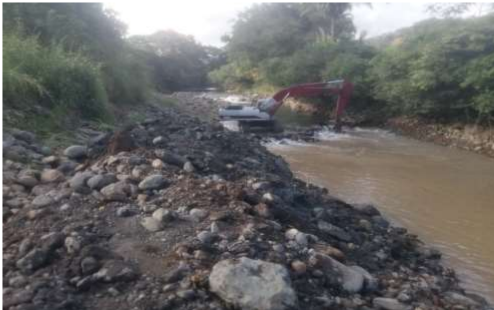
Fotografía 51. Trabajos en el sector de El Roble.
