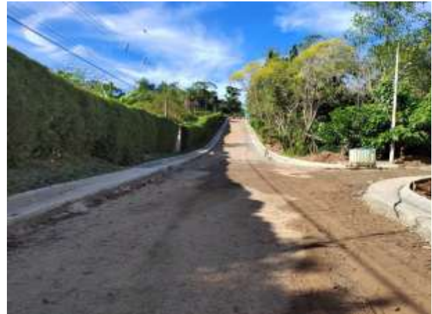
Fotografía 45. Proyecto en ejecución
