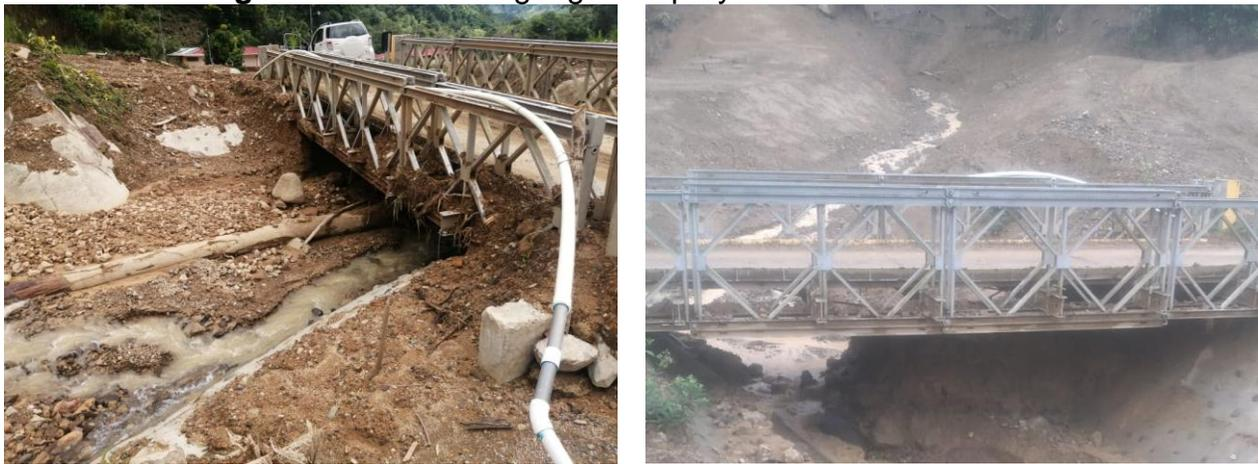
Fotografías N°55: Trabajos de dragado y conformación de cauce.
