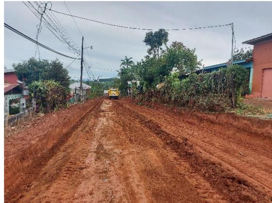
**Figura 5.** Gaveteo y conformación
