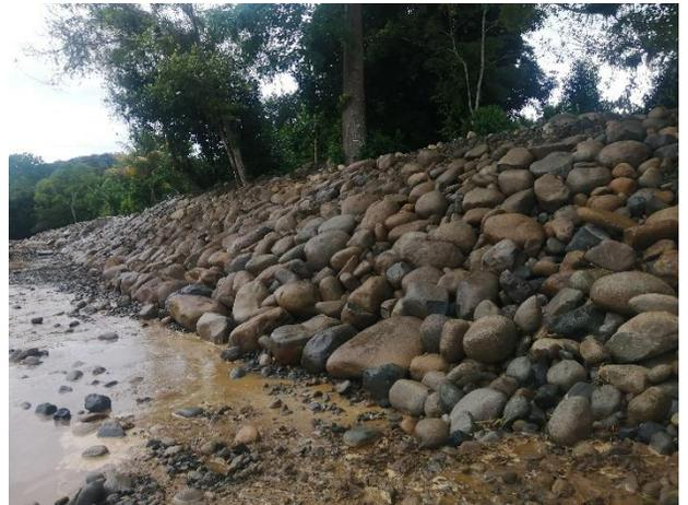
Fotografías N°53: Trabajos de dragado y conformación de dique.
