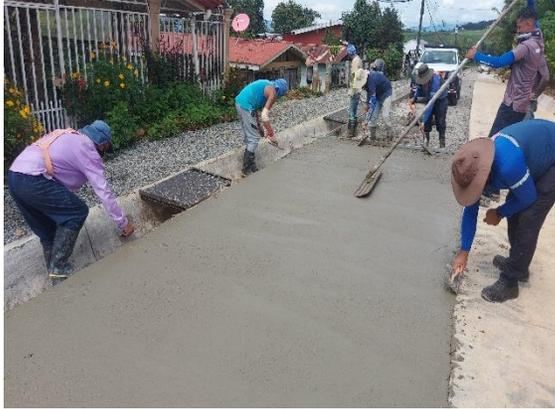
**Figura 6.** Construcción de losa.
