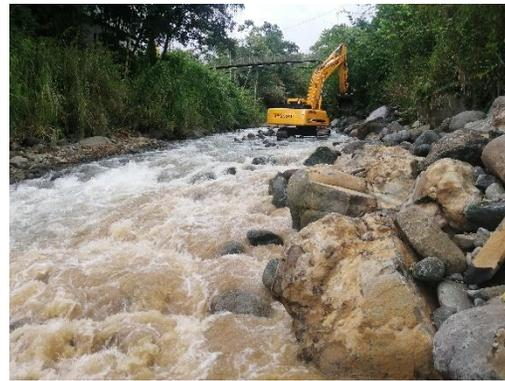
Fotografías N°57: Trabajos de dragado y conformación de dique sector de San Ramón Sur
